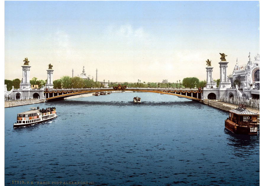
Fig. 5. El espectacular diseño del tablero del puente, que evita apoyarse sobre el río Sena, dejando libre el paso para la circulación fluvial sin ningún obstáculo, es considerado un hito de la ingeniería. Postal de la Exposición Universal de 1900
