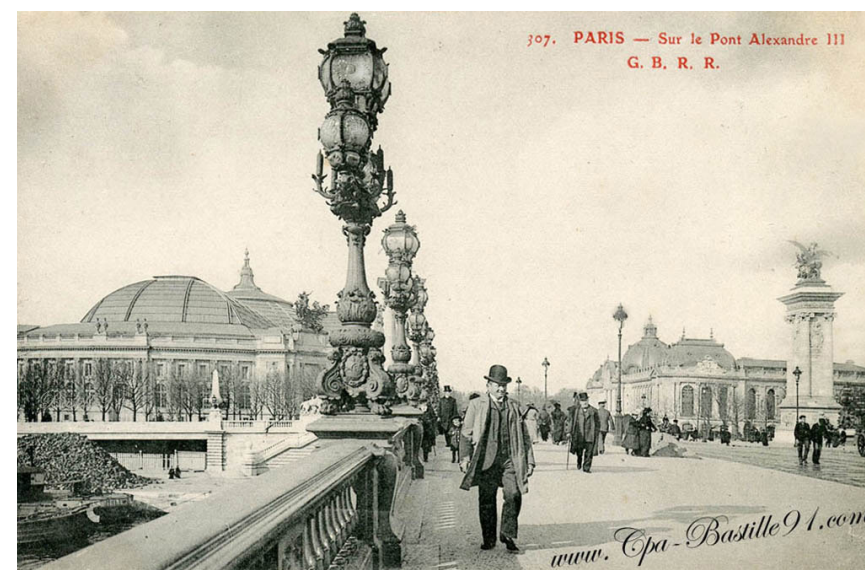
Fig. 2. Puente de Alejandro III, con el Grand Palais y el Petit Palais al fondo
